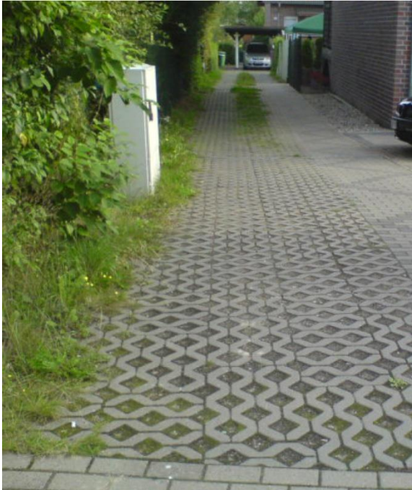
Figur 18. Exempel på genomsläpplig betongbeläggning. Källa: Stockholms stad, 2018.
